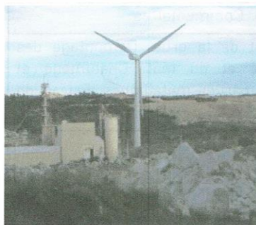
Figure 10- Eolienne de Centernach
