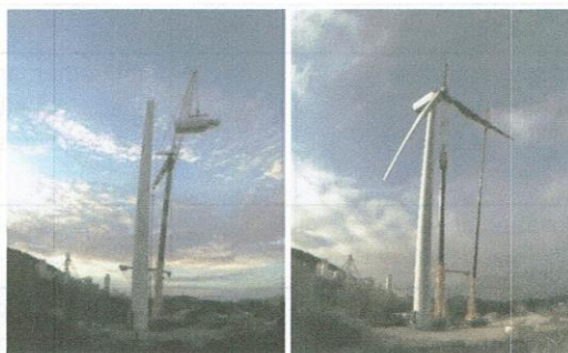
Figure 11- Démantèlement de l'éolienne
